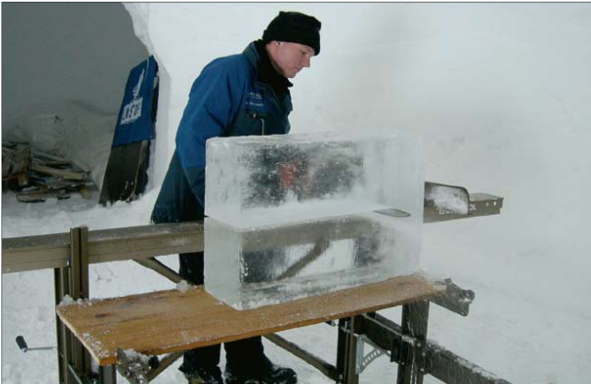
Für Tische und Bänke werden große Eisblöcke mit der M7 maßgenau geschnitten. Da Eis als Werkstoff aggressiver in der Verarbeitung ist als Holz, muss die Kette öfter geschärft werden.
