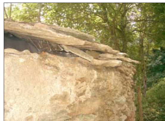
Die alten Dachsteine wurden mit Mörtel fixiert und verbergen die durch eine Teichfolie vor Feuchtigkeit geschützte Birnenholzdecke.
