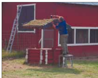
Ein Brunnenhaus in Blockhausbau-Weise entsteht. Dr. Meino Jauch sägt die Bohlen vor Ort mit seiner M7 mit Motorsägen-betriebenen Fräsaufsatz für Blockbohlen. Die Bohlen werden gesetzt und die Hohlkehlen ausgesägt. Kristin Jauch streicht in Schweden-Rot. Die Dachbegrünung aus Grassoden wird auf einer darunterliegenden Noppenfolie befestigt.
