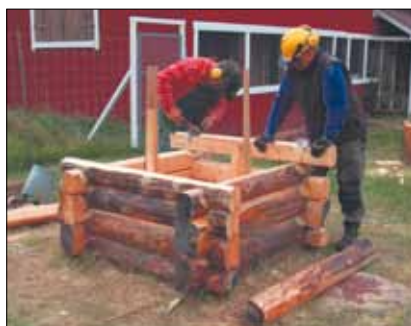
Ein Brunnenhaus in Blockhausbau-Weise entsteht. Dr. Meino Jauch sägt die Bohlen vor Ort mit seiner M7 mit Motorsägen-betriebenen Fräsaufsatz für Blockbohlen. Die Bohlen werden gesetzt und die Hohlkehlen ausgesägt. Kristin Jauch streicht in Schweden-Rot. Die Dachbegrünung aus Grassoden wird auf einer darunterliegenden Noppenfolie befestigt.
