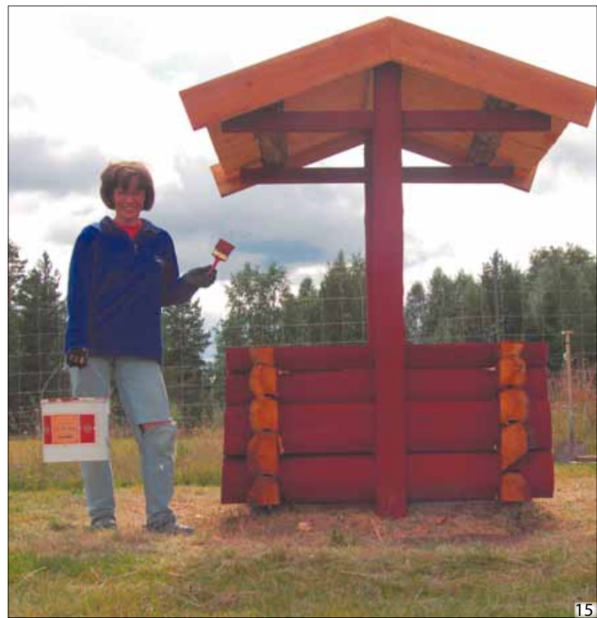
Ein Brunnenhaus in Blockhausbau-Weise entsteht. Dr. Meino Jauch sägt die Bohlen vor Ort mit seiner M7 mit Motorsägen-betriebenen Fräsaufsatz für Blockbohlen. Die Bohlen werden gesetzt und die Hohlkehlen ausgesägt. Kristin Jauch streicht in Schweden-Rot. Die Dachbegrünung aus Grassoden wird auf einer darunterliegenden Noppenfolie befestigt.
