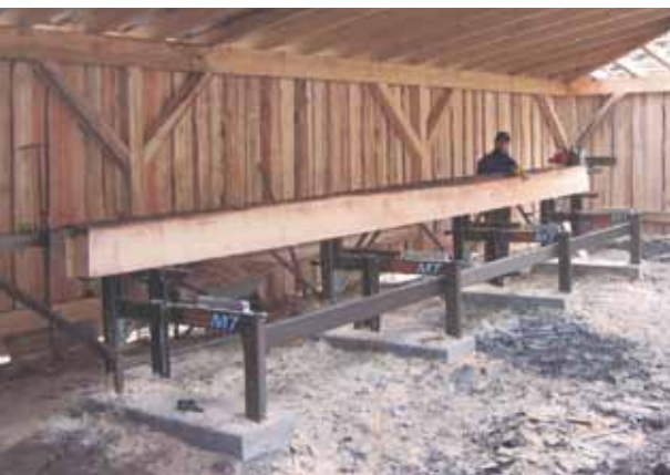
Mit der M7 mit Verlängerung können ganze Stämme aus dem Privatwald von Michael Reimold für den Blockhausbau vor Ort verarbeitet werden.
