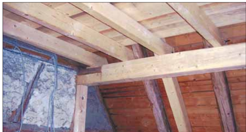
Genau nach Plan des Architekten und den Berechnungen des Statikers wurden Deckenbalken verlegt, marode Pfetten und Sparren ausgetauscht, das Kehlgebälke gelegt, und die Firstpfette aufgedoppelt.
