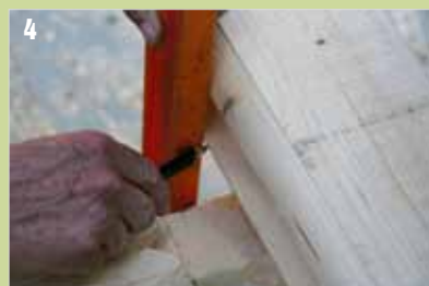
4 Das erste Holz der Querwand wird angerissen.
