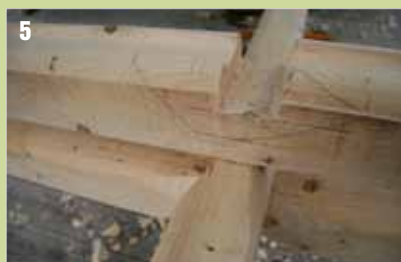
5 Halb ausgearbeitete Verkämmung.
