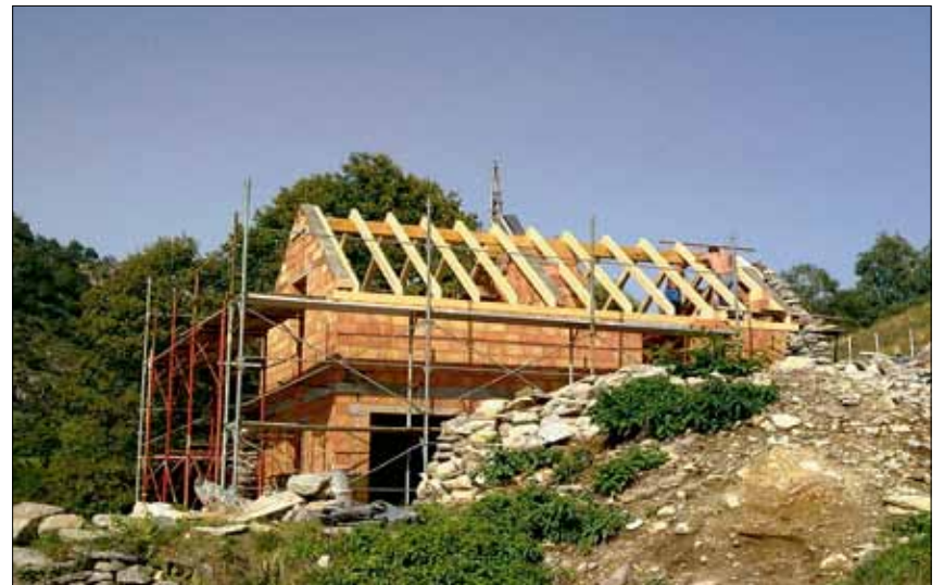
Das neue Rustico im Rohbau mit Firstbalken aus Kastanie.
