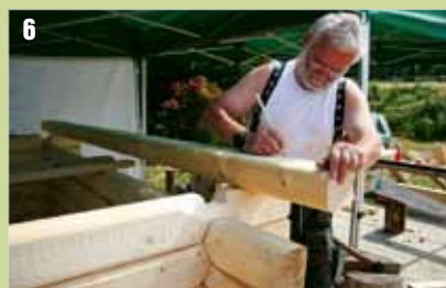
6 Erich Pohl beim Anreißen einer Verkämmung.
