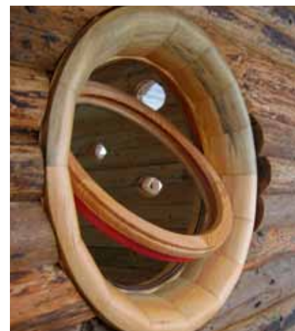
Dieses runde Astloch-Fenster ist keine Standardlösung, sondern es steckt viel ausgefeilte Technik in der Holzrundung, ebenso im individuell angefertigten Scharnier.
