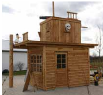
• Das Piratenhaus dient in der Minigolfanlage auch als Kiosk für die Schlägerausgabe. Daher hat Richard Orner Wände und Dach isoliert.
