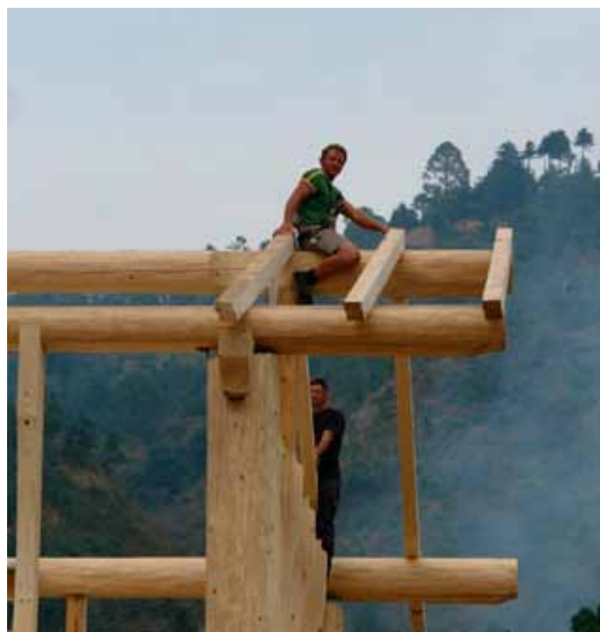
• Das Dach wird aufgerichtet.
