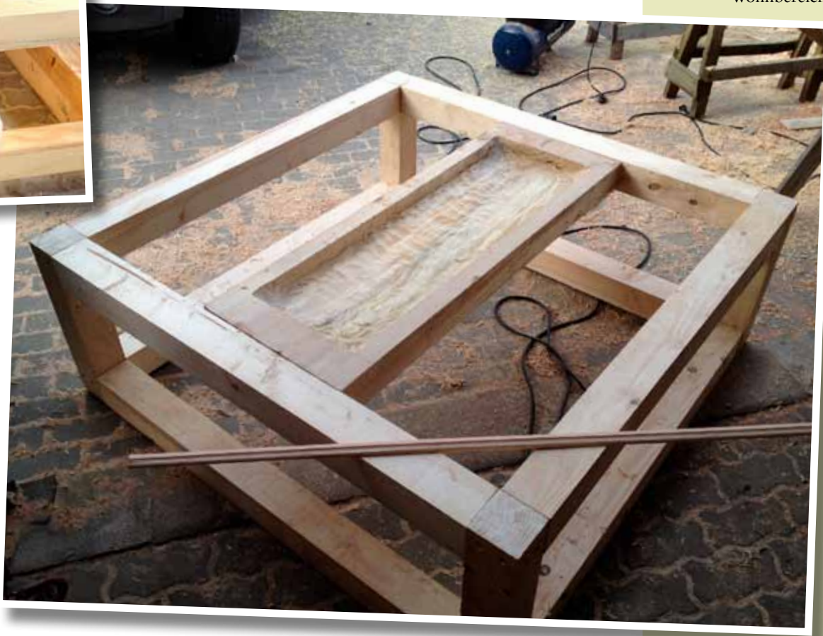
• Die Unterkonstruktion des Mini-Gradierwerks ist fertig; die Fächer unten sind für die Salzsteine. Die Wanne in der Mitte ist aus Holz und fängt bei Betrieb die Salzsole auf.
