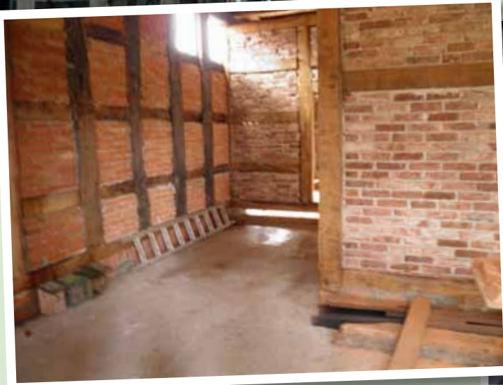
• Sowohl Innen- als auch Außenwände bestehen aus Fachständern und wurden traditionell wieder mit Sichtziegeln ausgefüllt.
