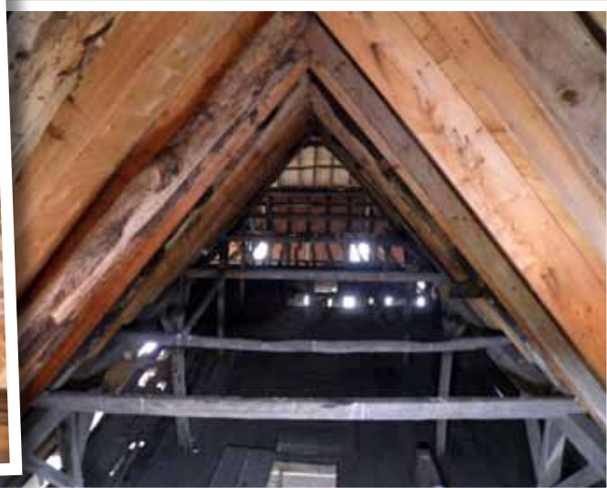
• Die Räume im ehemaligen Kornboden sollen von Tochter Lea bewohnt werden. Zusätzliche Fenster innerhalb der vorhandenen Fachwerkkonstruktion des Nordgiebels sorgen für eine bessere Belichtung.
