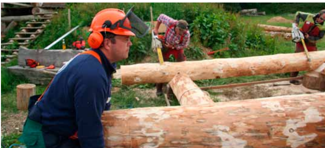
• Die Kursteilnehmer arbeiten Hand in Hand: Solange die einen noch eine Stammlage einpassen, sägen die anderen bereits die neuen Sättel aus.
