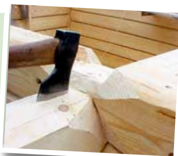
• Die Kursteilnehmer arbeiten Hand in Hand: Solange die einen noch eine Stammlage einpassen, sägen die anderen bereits die neuen Sättel aus.
