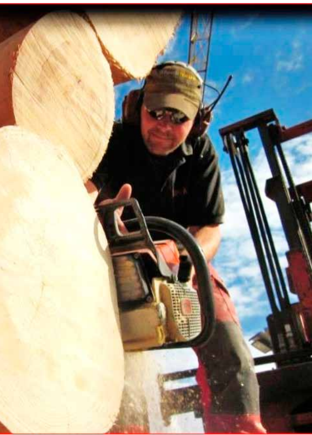
innen Überstände besäumt und Fenster ausgesägt werden.
