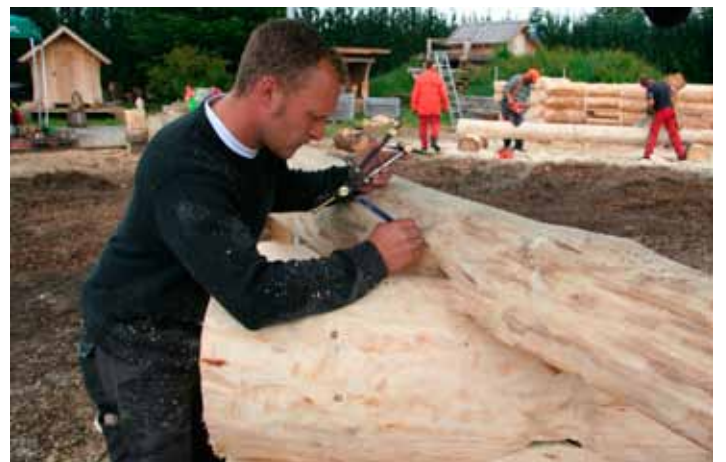
• Mit Hilfe des Blockhauszirkels wird die die Kontur des Sattels deckungsgleich auf den nächsten Stamm übertragen.
