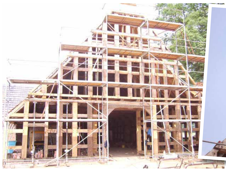
• Die meisten Wände des Eichenständerfachwerkhauses waren durch starke Setzungen zerstört und renovierungsbedürftig.
