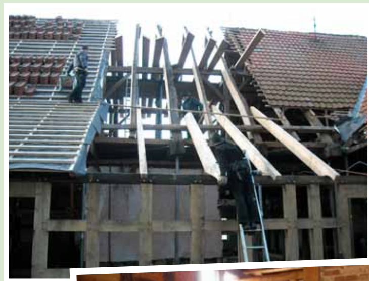
• Die meisten Wände des Eichenständerfachwerkhauses waren durch starke Setzungen zerstört und renovierungsbedürftig.
