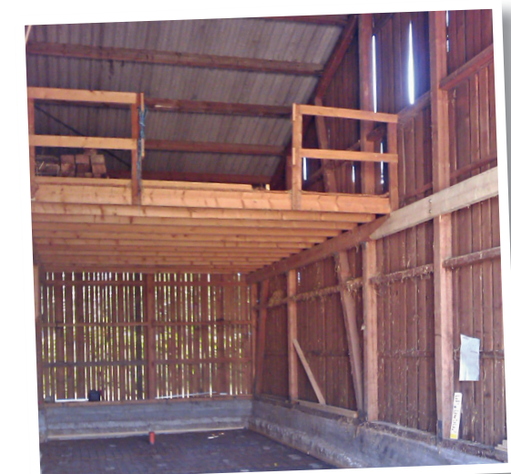
• Die Scheunen-Parzelle für die Werkstatt: Zwei Tragebalken wurden für die Geschossdeckenverlängerung eingezogen. Der Boden ist für eine Betonplatte präpariert.
