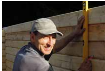
• Rasso Völk prüft, ob die Blöcke im Wasser sind.
