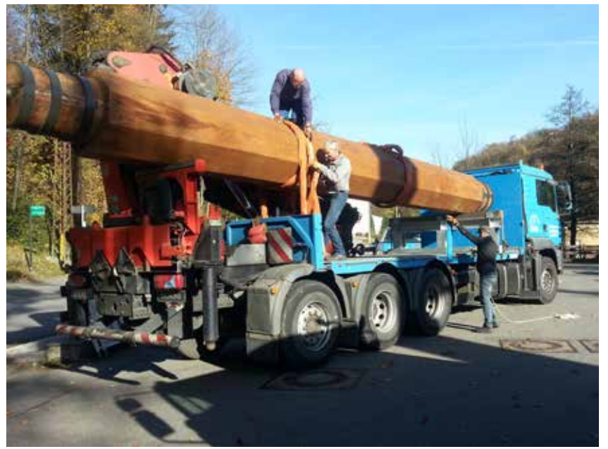
• Mit einem Schwertransport wird die neue Welle nach Annaberg-Buchholz geliefert. Für den Einbau des Eichenriesen sind drei Wochen anberaumt.
