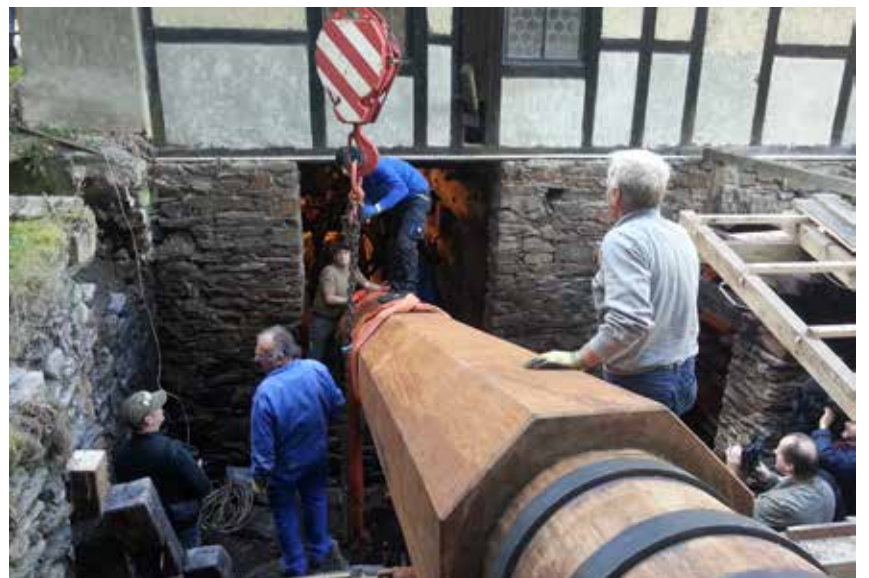
• Die neue Welle wird in das Hammerwerk eingebaut; das Wassermühlrad musste dafür vorübergehend ausgebaut werden.
