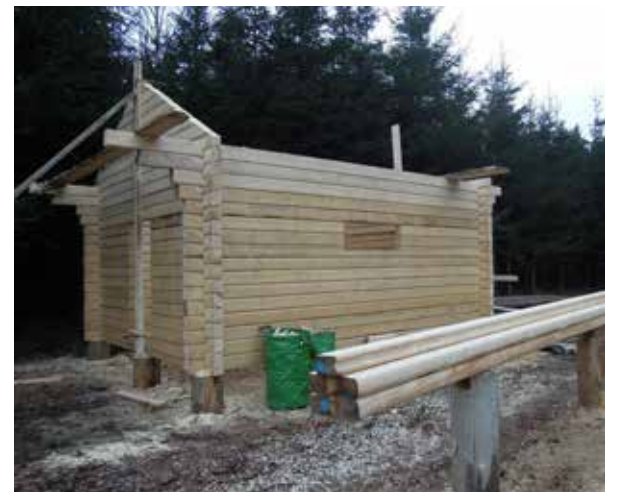
• Das Blockhaus im Aufbau ruht auf vier Stammblöcken. Jede Blocklage ist durchnummeriert, um einen Ab- und wieder Aufbau zu ermöglichen.
