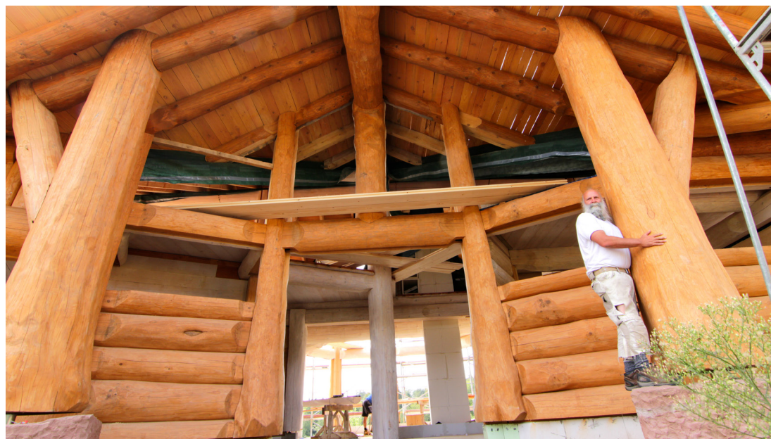
• Bruce in seiner Fertigungshalle, in der Wände aus ganzen Stämmen in Handarbeit vorgefertigt werden.
