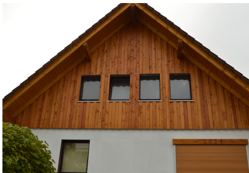
• Mit Hilfe des M8 gelang es, den Giebel des Hauses von Sohn Thomas zu verlängern und anschließend zu verschalen.
