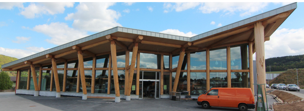
• Der Naturkostladen „Paradieschen“ mit freien Spannweiten bis zu 16 Metern gilt als das größte handgefertigte Post & Beam Gebäude Europas.
