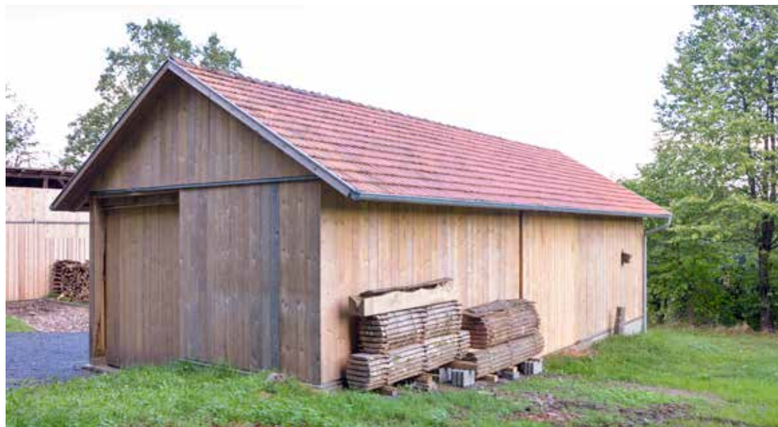
• Die 6 mal 15 Meter Gerätehalle hat Helmut Handwerker 2016 selbst geplant und in Holzständerbauweise ausgeführt.
