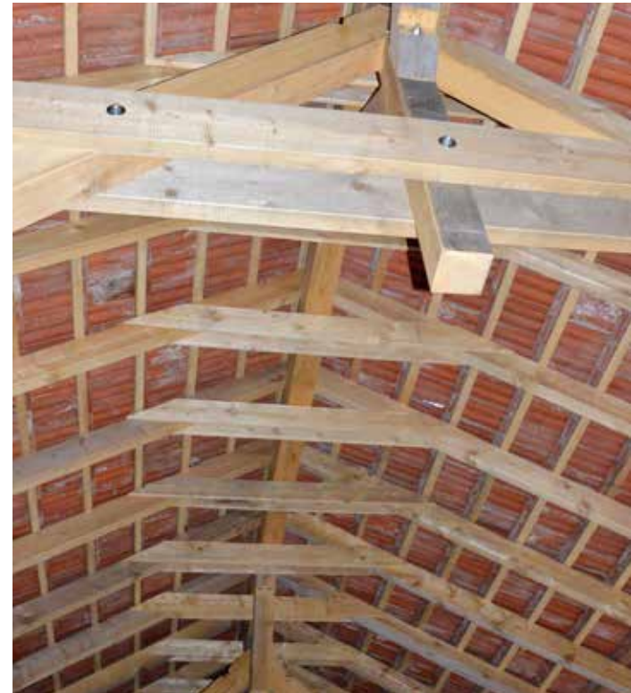
• Für die Stabilität des 15 Meter langen Daches hat Helmut zwei Strebenböcke eingezogen.
