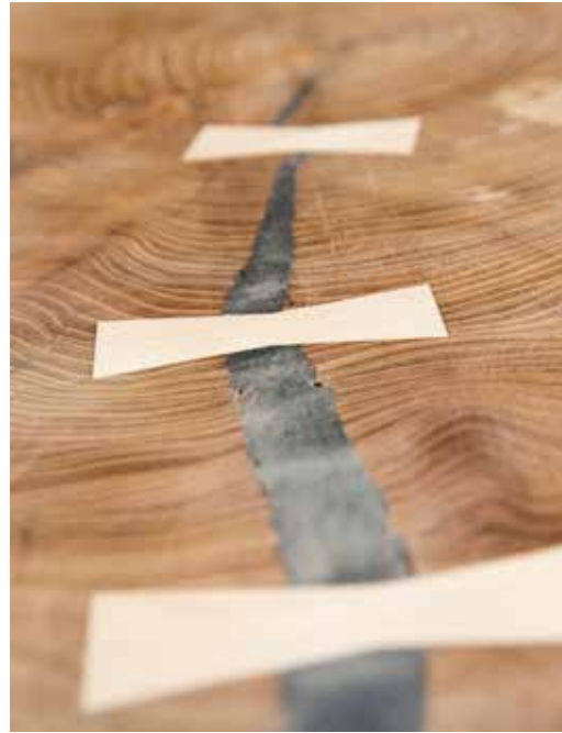
• Um die Risse zu stabilisieren, baut Alexander ein dekoratives Schließstück ein, beispielsweise in Form eines Schmetterlings oder einer Rose; mit exakter Passform, welche die Bretter oder Dielen zusammenhält.
