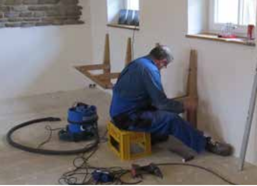
• Reinhold Thiel bei der Montage der Gaststättenbänke, für die er 3 x 10mm-Schlüssel-schrauben und Montagekleber verwendete.
