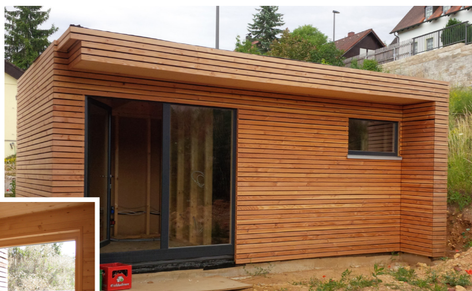
• Die finnische Sauna ist aus Vollholz, auf einem Betonfundament gebaut und öffnet sich mit großer Fensterfront in den Garten.
