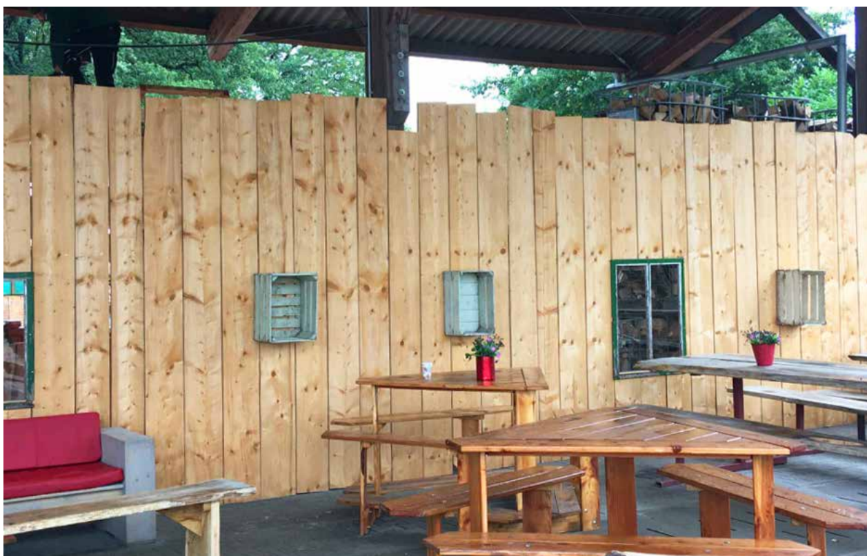
• Das große Vordach, das Markus mit Lärche aus dem eigenen Forst verkleidet hat, bietet für viele Veranstaltungen übers Jahr einen dekorativen Rahmen.
