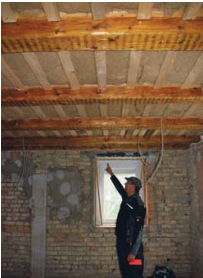
• Erstlingswerk: den Decken-Balken hat Martin bereits mit seinem Logosol F2 plus auf genaues Maß gesägt und ausgetauscht.
