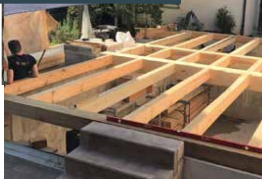
• Die unterste Geschossdecke besteht aus einem Massivholzskelett, das dann für die Dämmung Brett um Brett aufgefüllt wurde.
