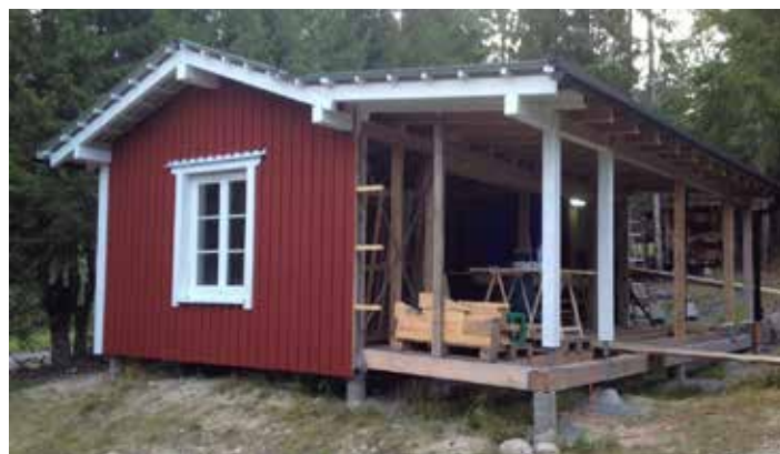
• Wolfgang's neue Werkstatt, in typischem Schwedenstil, mit Anbau ist fast fertig.
