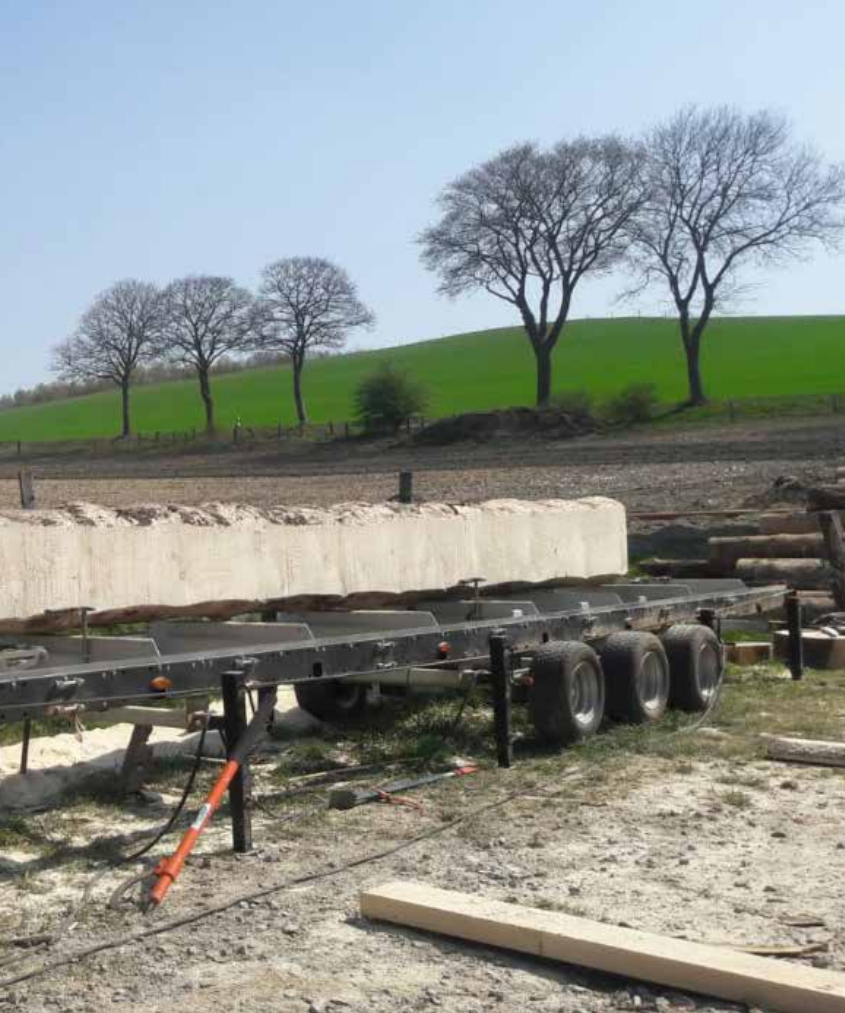
• Für das Sägen in hohen Dimensionen: Am Bandsägewerk B1001 wurde das Sägebett auf 9,50 Meter verlängert und mit Trailer-Kit auch mobil.
