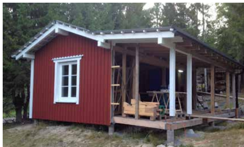
• Wolfgang's neue Werkstatt, in typischem Schwedenstil, mit Anbau ist fast fertig.
