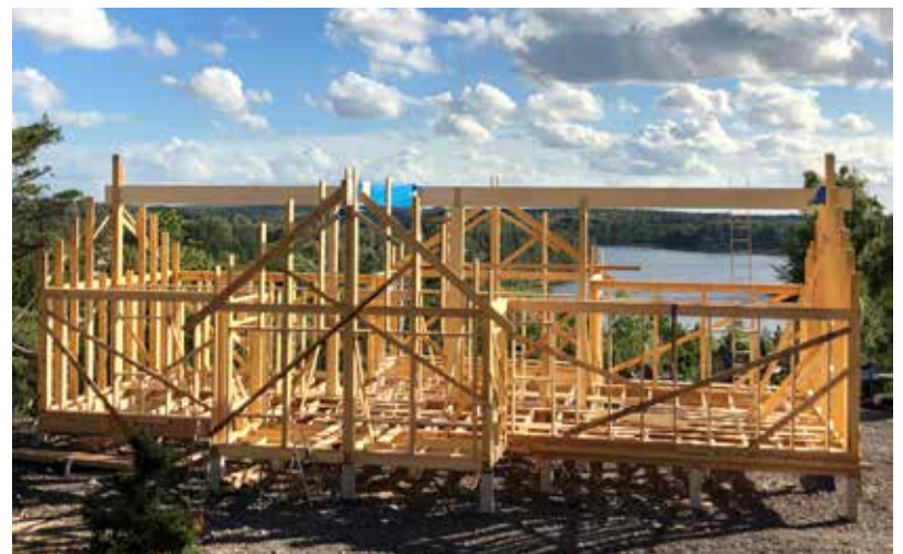
• Das gesamte Holz für das Haus, mit Ausnahme der Firstbalken, wurde selbst gesägt.
