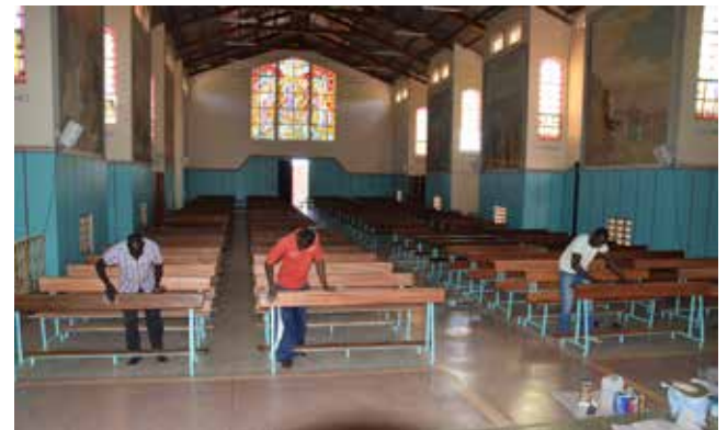
• Die Montage der in der Tischlerei gefertigten Kirchenbänke in der Kathedrale von Lira.
