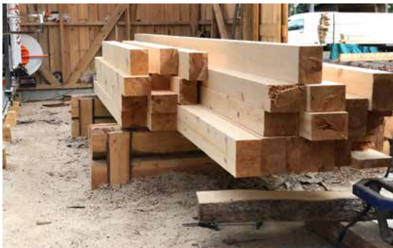
• Solide Stützbalken für das Fundament des Hauses wurden gesägt.
