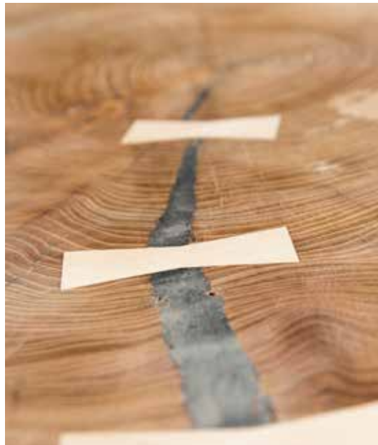
• Um Risse zu stabilisieren, verwendet Alexander eine dekorative Verbindungstechnik, bei der er ein Verriegelungsstück in Form einer Schleife oder einer Rose einsetzt, das präzise passt und die Bretter zusammenhält.
