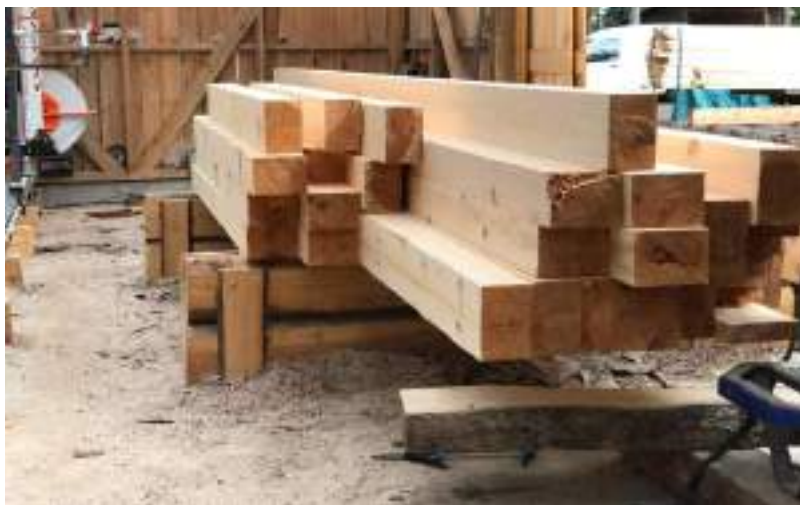
• Solide Stützbalken für das Fundament wurden zugeschnitten.
