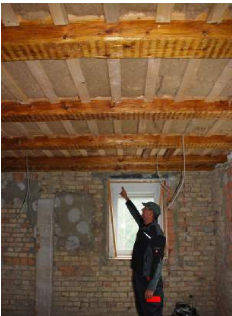
• Erstlingswerk: den Deckenbalken hat Martin bereits mit seinem Logosol F2+ auf genaues Maß gesägt und ausgetauscht.
