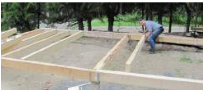
• Auf das Punktfundament aus Beton setzt Wolfgang den Holzrahmen für den Fußboden. Die Holzständerbauweise wird bis unters Dach fortgesetzt und alles mit Metallwinkeln verbunden. Die Schalungsbretter erhalten die schwedentypische rote Farbe - Faluröd.
