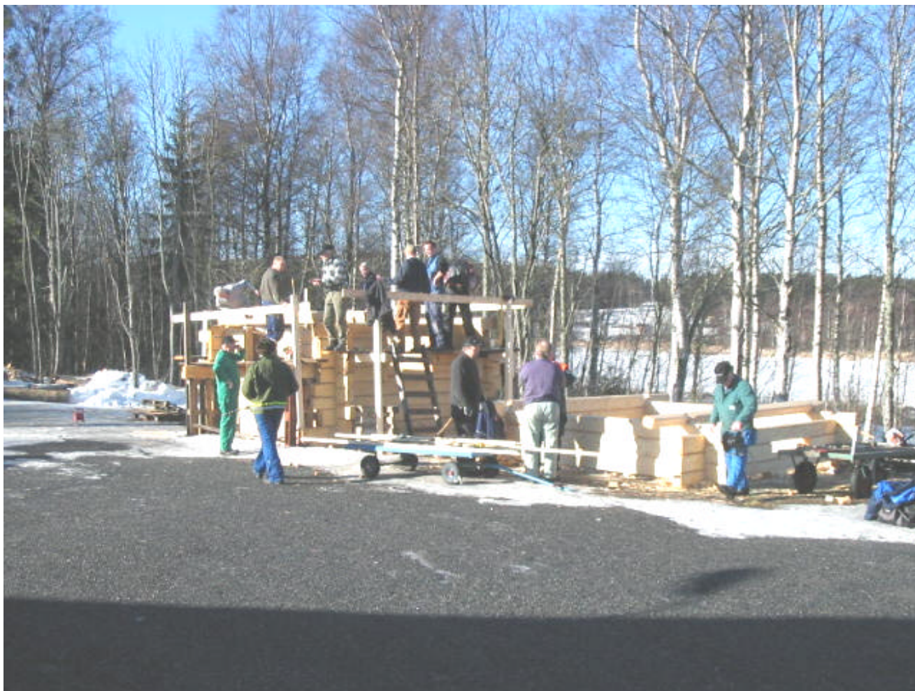
Курс строительства срубов на Logosol в Швеции
