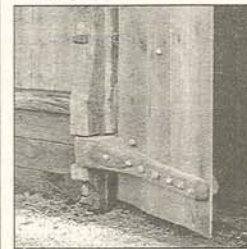
I forntidshuset finns inte en enda spik. T o m gångjärnen är av trä.
