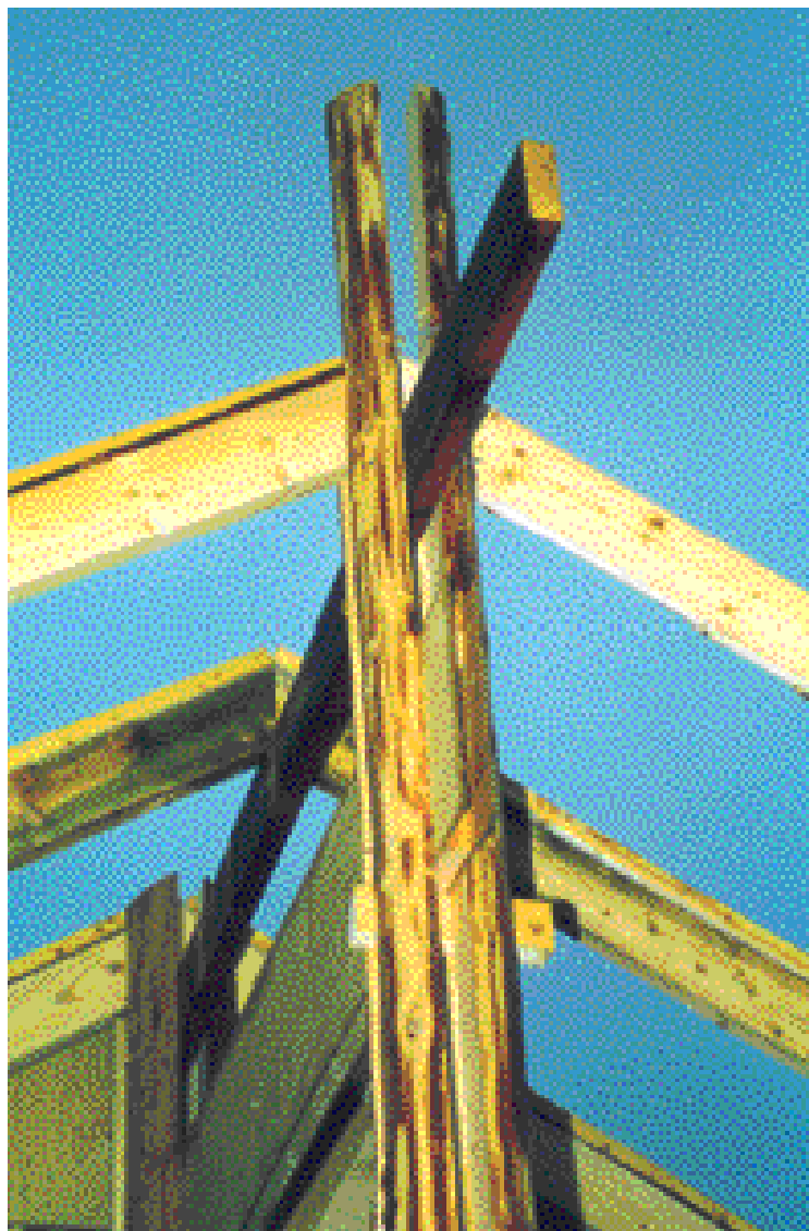
En av grundidéerna i byggsystemet är att snabbt uppföra en gles stomme så att större delen av bygget kan ske under tak. Stommen kan byggas av rått virke, genom en konstruktion med bultförband som gör att man kan "efterdra" huset när virket har torkat.
