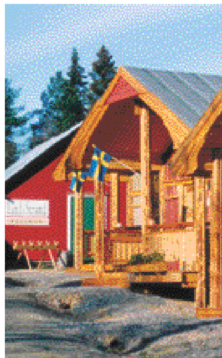
Två av de tre husen på Land & Strands Bottenviken utanför Kalix. Husen är byggda av rått virke och det mesta av träden har kommit till anv
