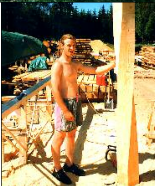
Bilden är inskickad av Ingbrith Arnell på Bygghyttan i Fengerfors. Den skruvade stolpe är avsedd för Kungajakt och Viltmuseet. Läs mer om bygget på sidan 17.
