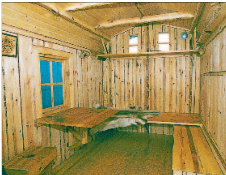
Den här stugan byggdes speciellt för övernattnig vid den årliga kolmilan. Allt virke är sågat med Solosågen och man har behållit vankanten på paneler och bänkar på ett mycket effektivt sätt.
