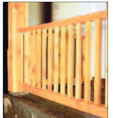
Räcket och pelarna är tillverkade av solosågad lärk. Ytan har behandlats med teakolja.
