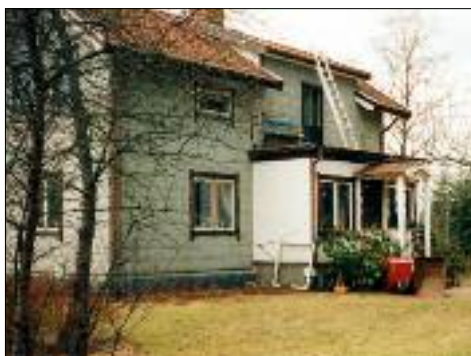
Huset före renovering.
