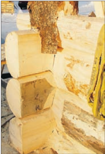
Stockarna klyvs så att innerväggarna blir släta.
