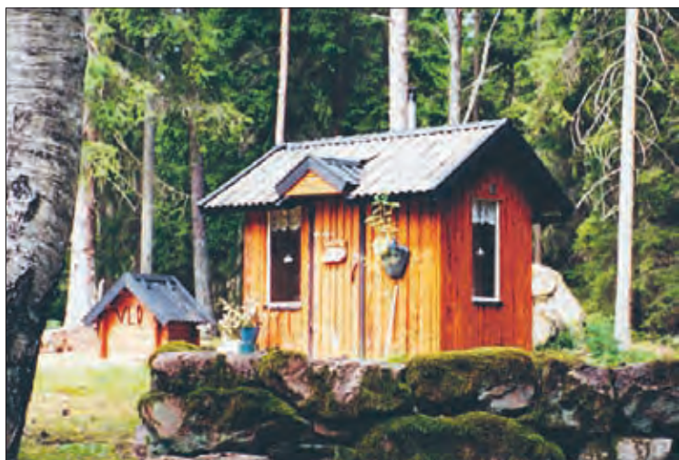
Solosåget är för många ett verktyg att förverkliga drömmar med. Det har Ingemar Petersson i Åseda gjort. Den här sagoboksliga jaktkojan är ett av hans verk.
