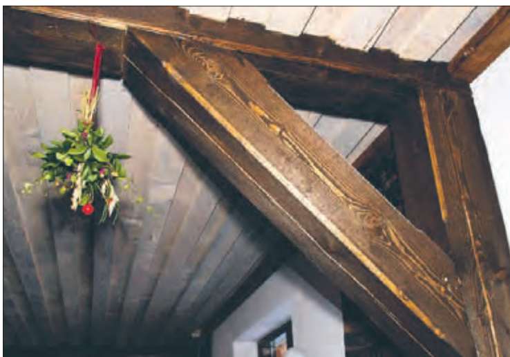
Bygget gick rekordsnabbt tack vare att stommen uppfördes i rätt virke som fick torka på plats.
