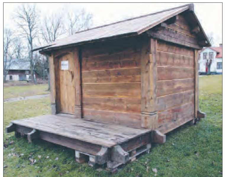
Bulhus är den gotländska varianten av skiftesverkshus. Även yttertakets är av trä, tjärat och med spår för vattenavrinning.
