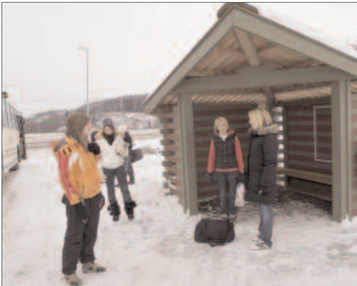
På sikt ska Timrå kommun bygga bortåt 40 busskurer av den här typen med hjälp av sin Solosåg.
