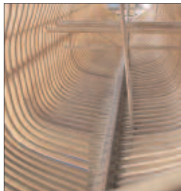
Spanten, fartygets skelett är tillverkat med konverterade Solosågar.
