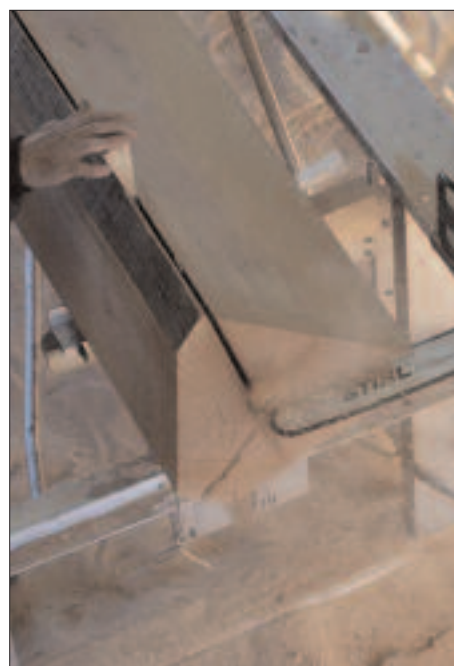
Taknocken sågades till slutlig form direkt på bitar och blev totalt 16 meter lång. Nedan syns en detalj av taknocken.
