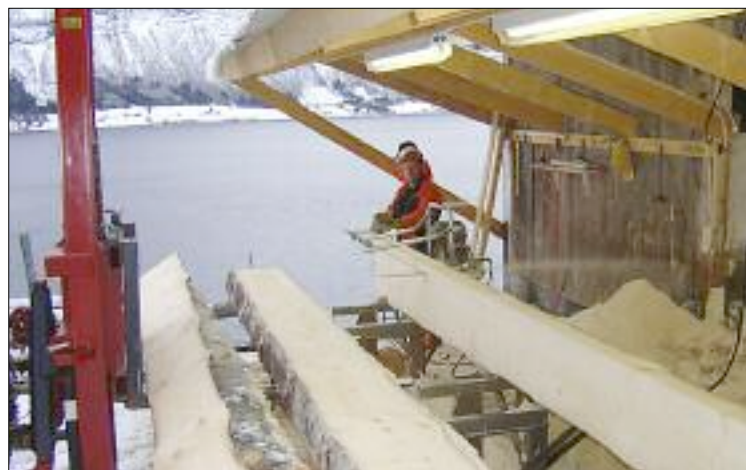
– Så langt har jeg saget og dimensjonert materialer til bruk ved bygging av nytt tak på låven, ca. 270 m 2 , sier Øystein Espelund.
