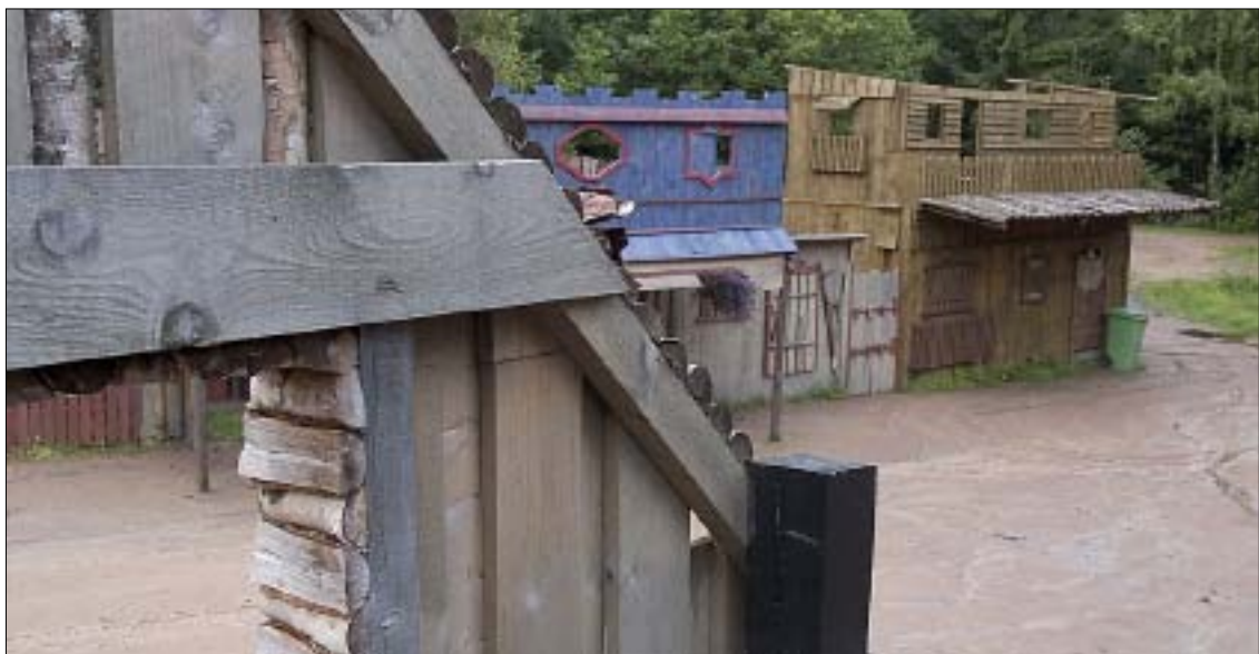
Gun City byggdes med rätt virke direkt från sågverket.
