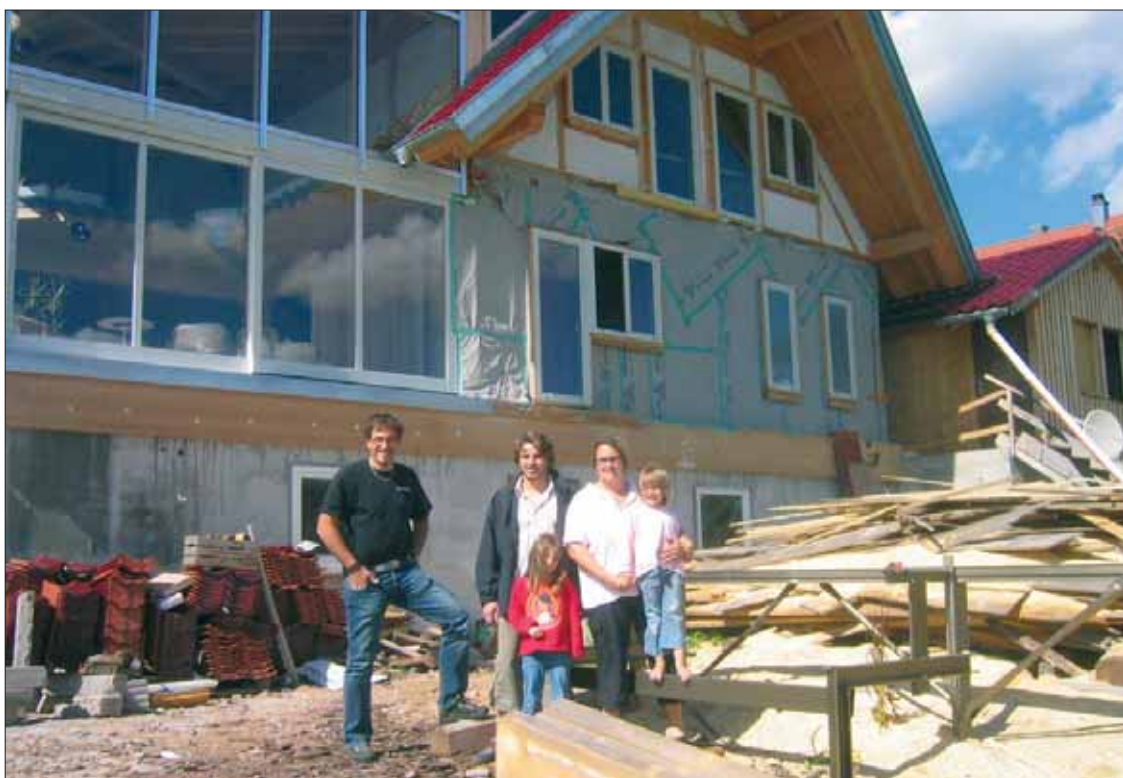
Familjen Pfeifer samlade runt Solosågen under bygget av villan. T v Logosols Henrik Sigurdson.
