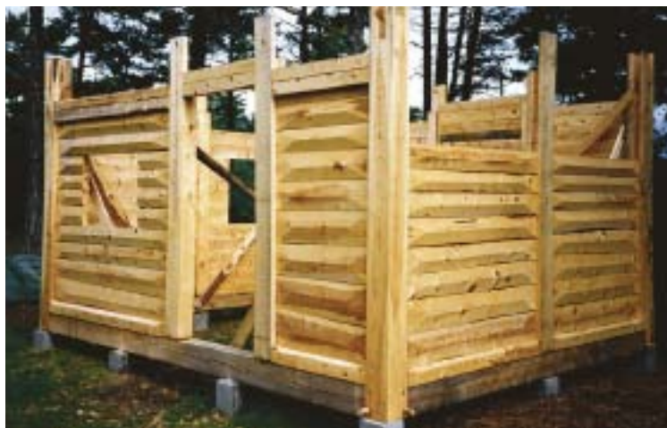
Ett av Bo Hagbergs bulhus under bygge. Notera åsarna på virket som sågats fram med en Solosåg.
