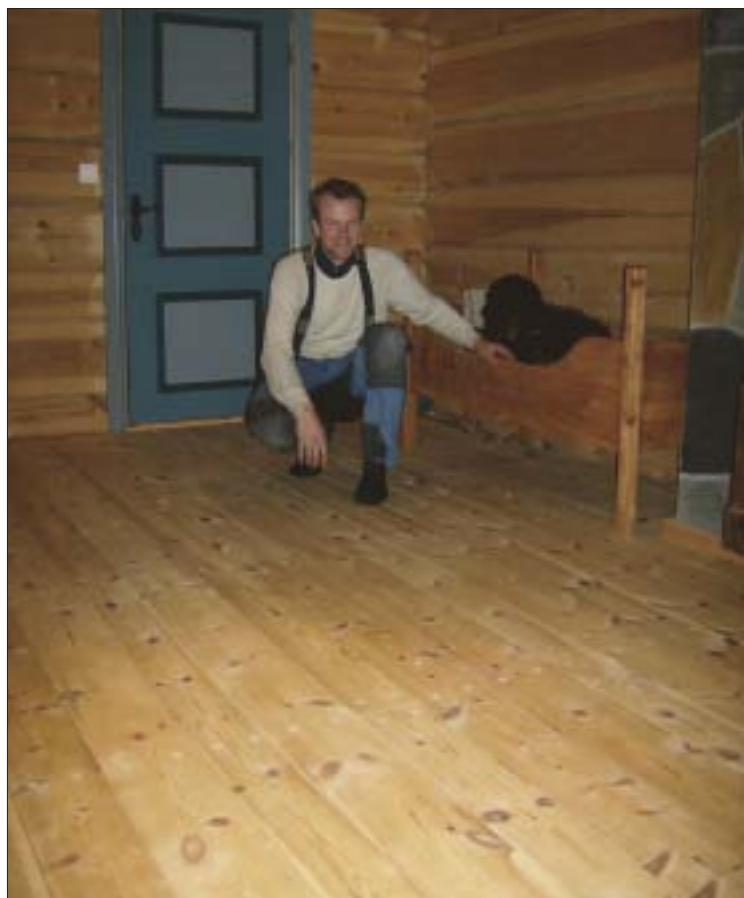
Både dobbelfalskledningen, panelene innvendig, golvbordene, underpanel og listverket produsert på egen høvel.
