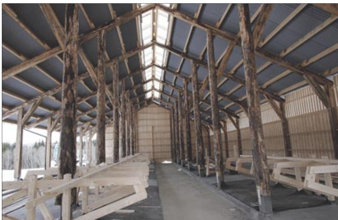
Bygget på Brandval er 16 meter bredt og 32 meter langt. Til bærekonstruksjonene ble det plukket ut stolper med minimum toppmål 25 centimeter, og med lengder inntil 7,3 meter.
