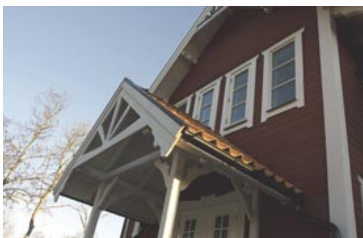
Grannhuset är nybyggt av solosågat virke. Ågaren har eget sågverk och Staffan Sandler hjälpte till med sitt.
