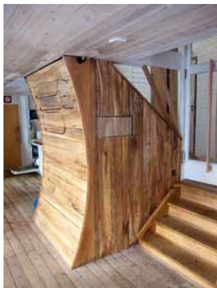
Akkumulatortanken är inbyggd i köket, under trappan till övervåningen
