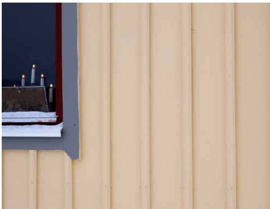
Hela fasaden till det gamla huset och utbyggnaden har hyvlats och dimensionerats med Solohyveln. Samma hyvel har använts för att tillverka den hattformade lockläkten.
