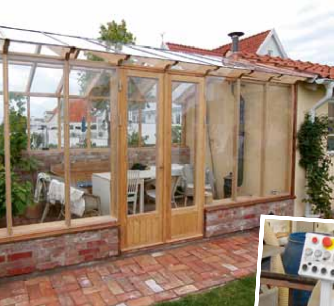
Komponenterna är tillverkade av PiF Specialsnickerier som även byggt växthuset.
