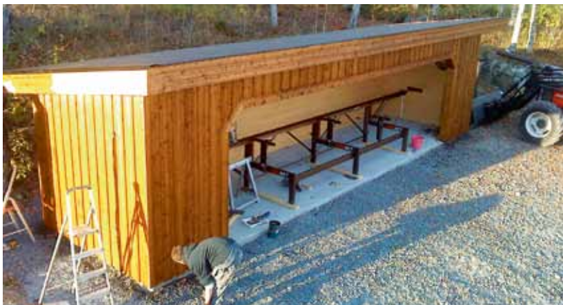
Ett prydligt såghus var familjen Öbergs byggkola för framtida projekt.
