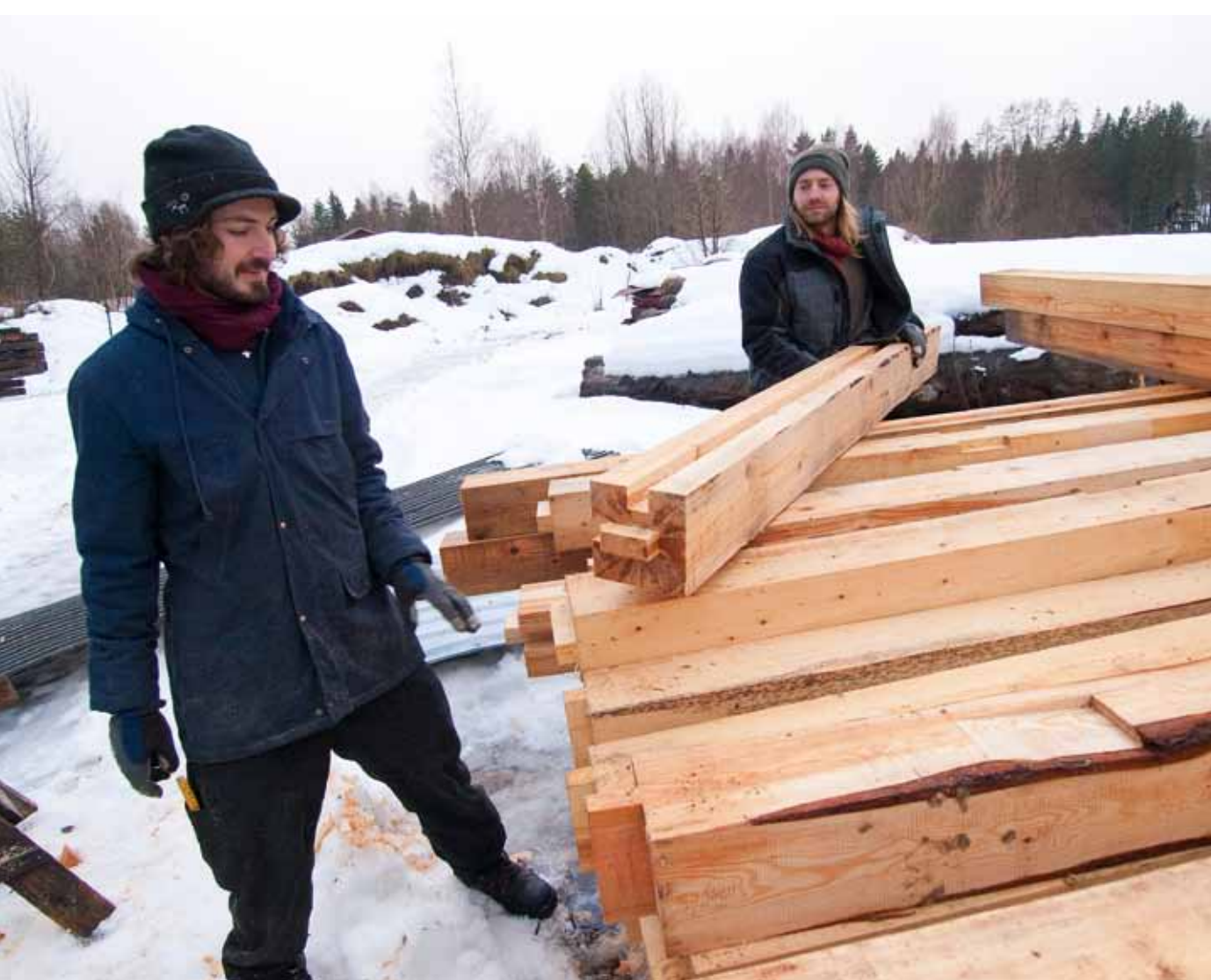
Verkstaden byggs i skiftesverk. Johannes Kabell och Timothy Ohdin visar stolparna som ska bära upp byggnaden.
