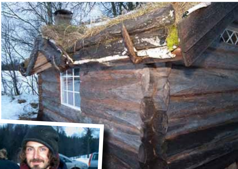
Stugan var examensprovet i utbildningen till timmerman. Johannes Kabell klöv de grova stockarna med en Solosåg och högg timret utanför knutarna ovala.
