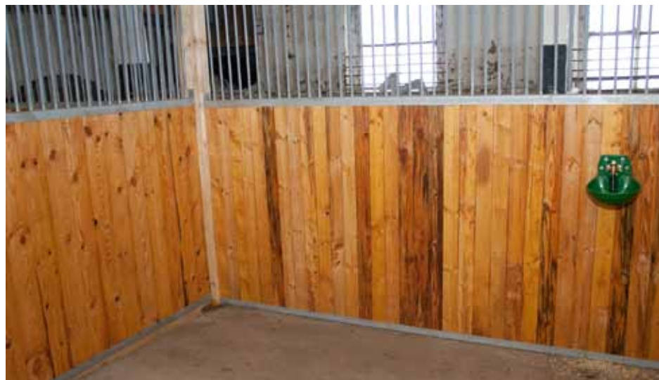
En av 18 nybyggda boxar i stallet. Virket är från egen skog och har behandlats med egenproducerad linolja.
