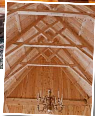
• Takkonstruksjonen inne i kirka.
