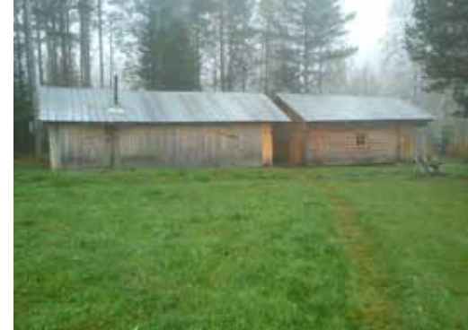
• Byggnaden med lada och ladugård färdigrenoverad.
