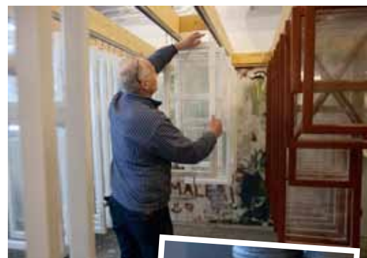
• Här målas bara fönster med linoljefärg. Så gjorde man förr och det håller. Tättningslist av lin och gamla tiders pappersremсор för tätning av fönster.
