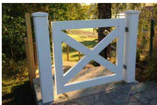
• Grind med grinstolpar, tillverkad i furu. Beslag i rostfritt stål
