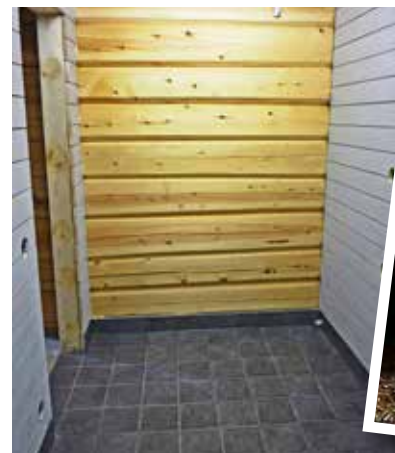
• Under 2013 färdigställdes tvättstugan i det nya huset för att få igång värmesystemet. Det blev fint kakel och träväggar med råplan som hyvlats med stål som ger grövre yta.
