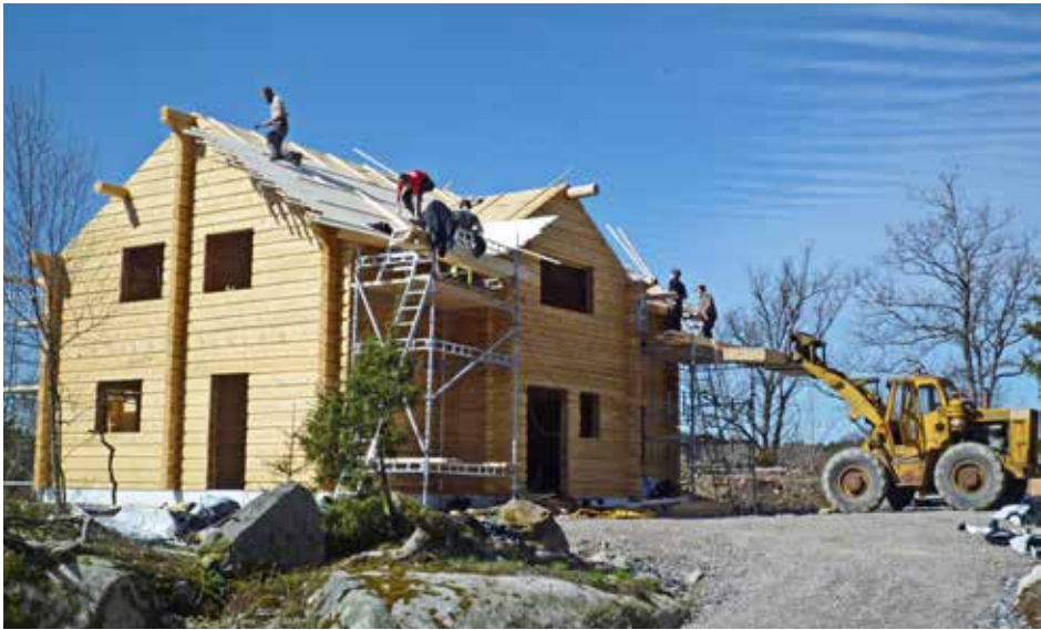
• Under våren 2012 restes timmerstommen och huset kom under tak med egentillverkad råspont.
