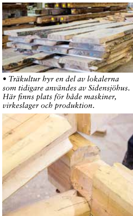
• Enkelhaksknuten är en rakare knut med hak på insidan. Knuten är vanlig i Ångermanland.
