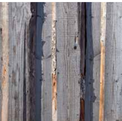
• Vindskyddet i hästhagen har Staffan byggt med egensågat, okantat virke och klätt invändigt med begagnad industriduk för att få det helt vindtätt.
