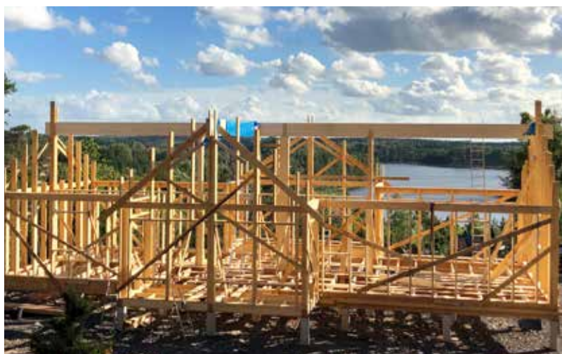
Allt virke till huset har Anders sågat själv, förutom limmträbalkarna.
