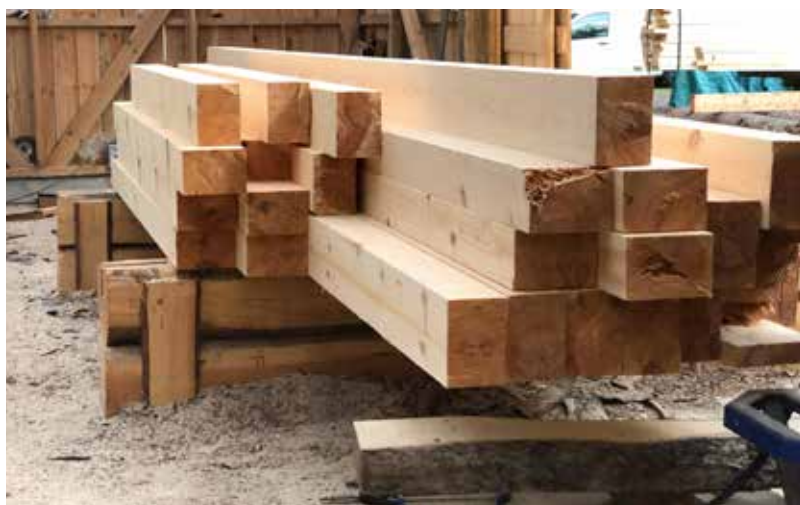
Rejåla bärlinor sågade till husgrunden.
