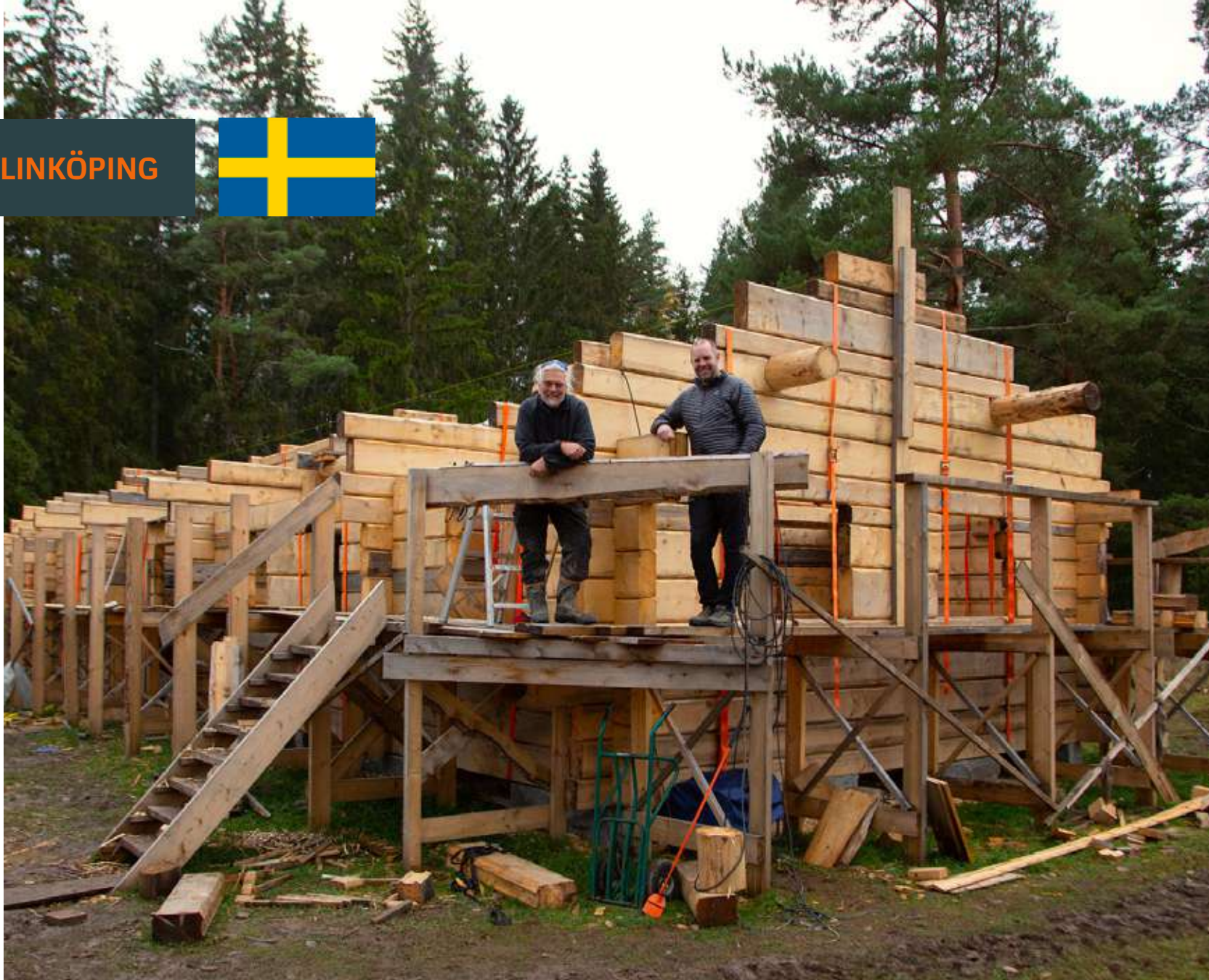
• Ulf Långström och Pablo von Eckarsdstein vid långhuset som timmras med hjälp av Ulf:s sågning och fräsning.
