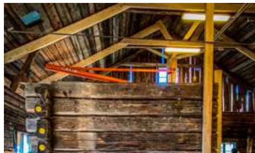
• Reparation av äldre timmerhus i f.d. verkstaden
