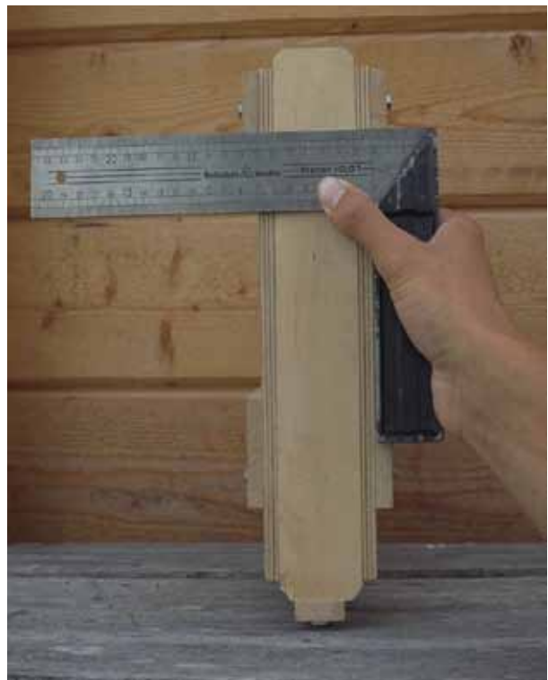
Kontrollera att listerna sitter mitt emot varandra.
