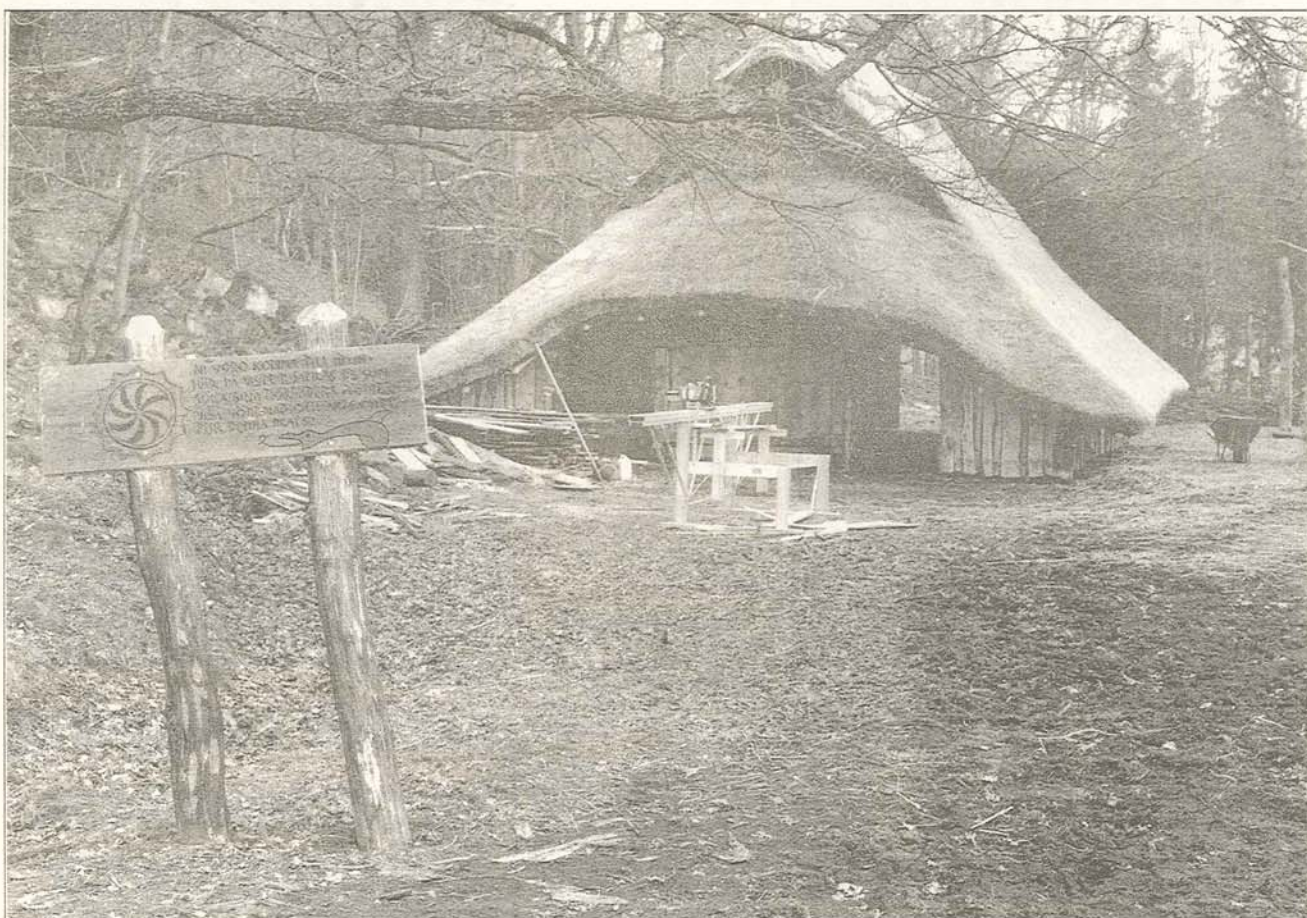
Virket till forntidshuset sågades på plats med Solosågen. Bara till halmtaget gick det åt 2000 löpmeter läkt.
