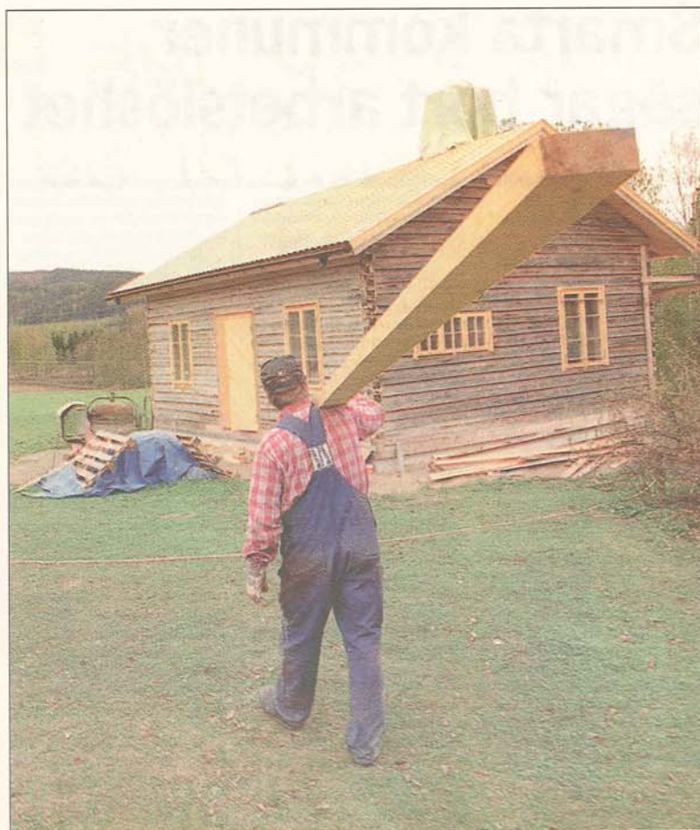
Efter bygget av "Norden största vedbod", har Björn Sprängare givit sig i kast med att resa och renovera ett gammalt timmerhus
