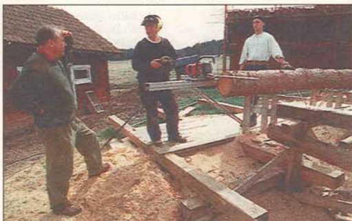
– Sågverket har gjort det möjligt för oss att tillverka virke som både till utseende och längd stämmer med det ursprungliga, säger arbetsledaren Bengt Lundvall (i mitten).
