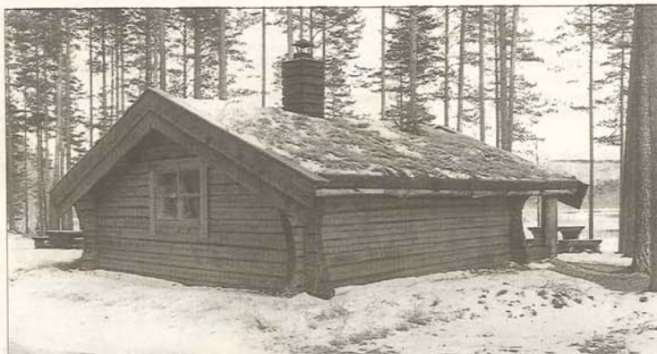
Tack vare eget sågverk har Grangärde fiske kunnat bygga rejäla övernattningsstugor vid flera sjöar i området. Allemansrätten gäller även inomhus och ofta finns även ved som besökarna får använda gratis. Veden är bl a spill från sågverket.
